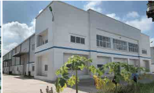
越南工厂 ITIGURA VIETNAM ベトナム工場
