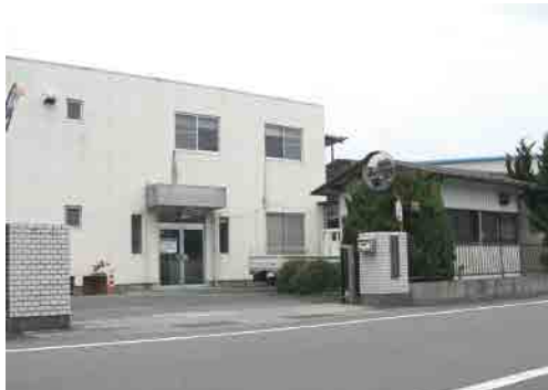
美浓加茂工厂 Minokamo plant 美濃加茂工場
